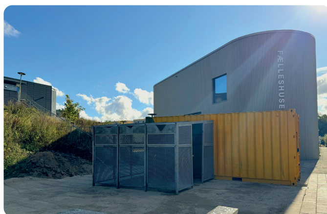
Info-området bygges op.
